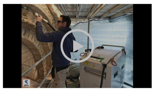
Découvrez la dernière vidéo publiée sur la chaîne Youtube de Silltec : Nettoyage laser d'une façade en pierre par la machine DRAGO Thick Mobile
